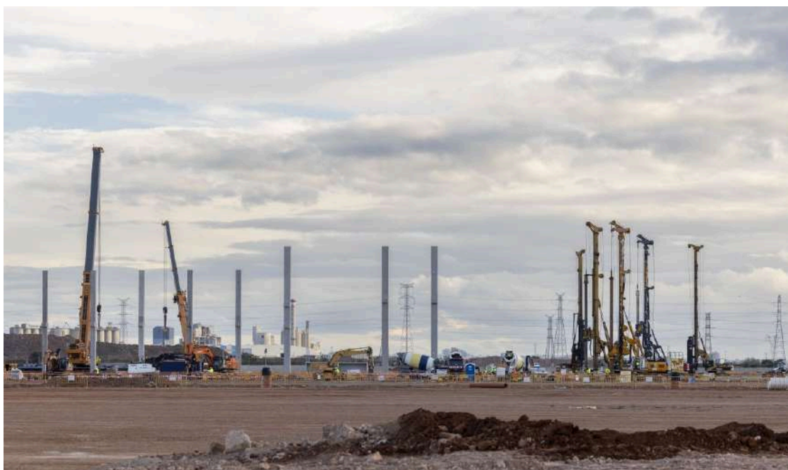
Obras de Powerco para la construcción de la gigafactoría en Sagunt Foto: MIGUEL LORENZO / POWERCO
