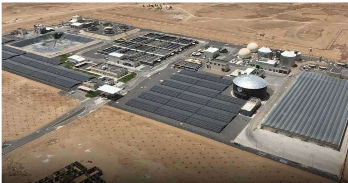
Acciona inicia la operación de tres depuradoras en Arabia Saudí
